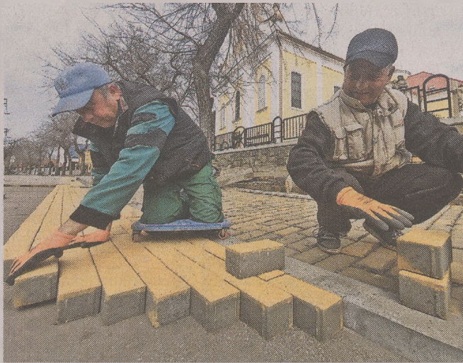
Jelenleg a térkövezés zajlik a Szentháromság téren Fotó: P. Á.
